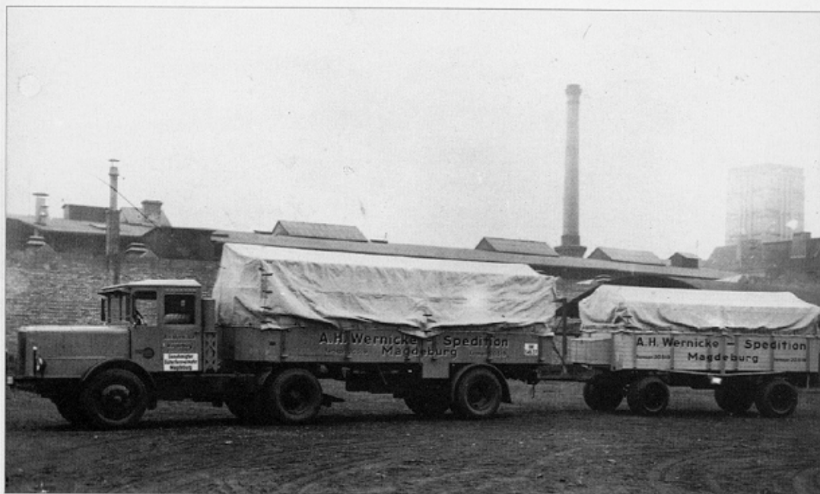
Der Sattelschlepperzug der Magdeburger Spedition Wernicke zeigt den Stand des Lkw zu Beginn der dreißiger Jahre: Luftbereifung, Druckluftbremse (auch für den Hänger) und elektrische Ausrüstung des Fahrzeugs Foto: Slg. Weinreich
