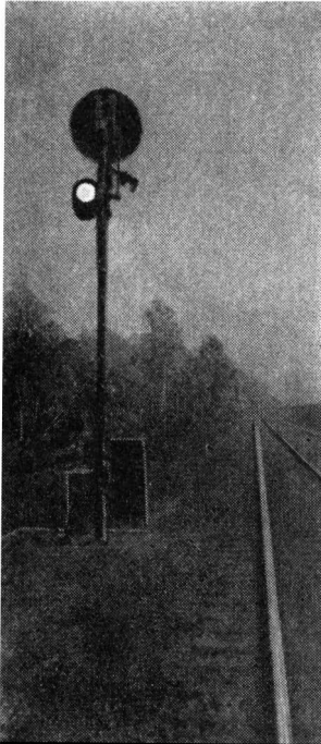
Bild 5 Signal Vf 0 bei Dunkelheit von rückwärts
